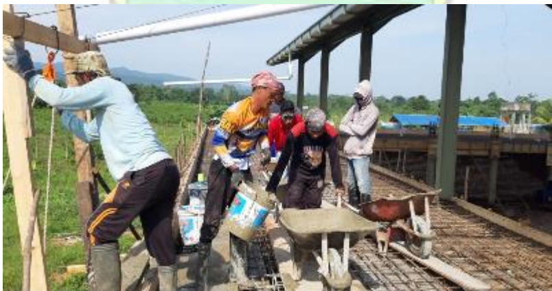
Foto pembangunan Gedung
