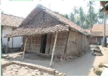
Gambar. Rumah tidak layak huni
