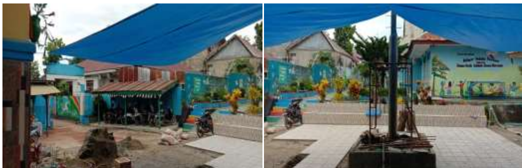
Gambar 4.5 Proses perbaikan gedung induk dan halaman sekolah
