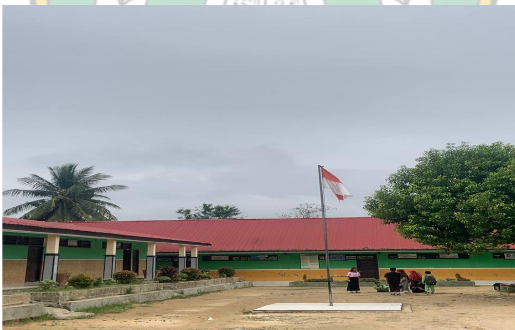
Dokumentasi 9: Bangunan SDN 7 Ranomeeto
