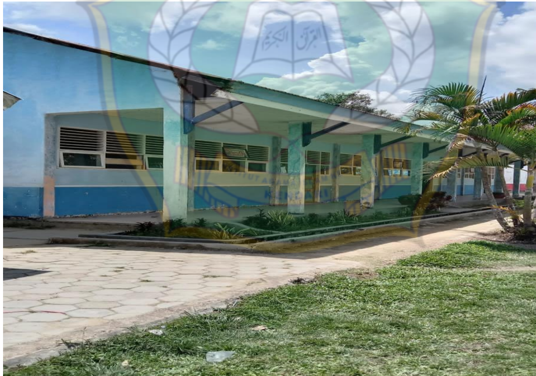
Gedung kelas putra
