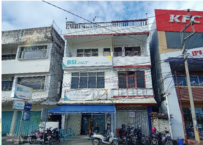
G. 5.1 Kantor BSI KCP Baubau Yos Sudarso
