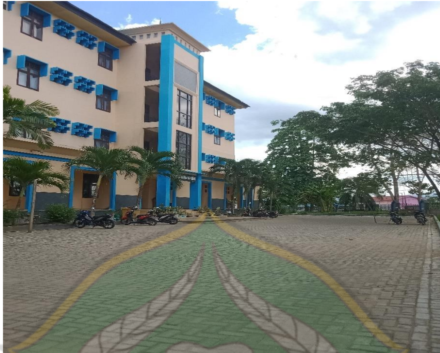
Gambar 1. Gedung Ma'had Al-Jami'ah IAIN Kendari
