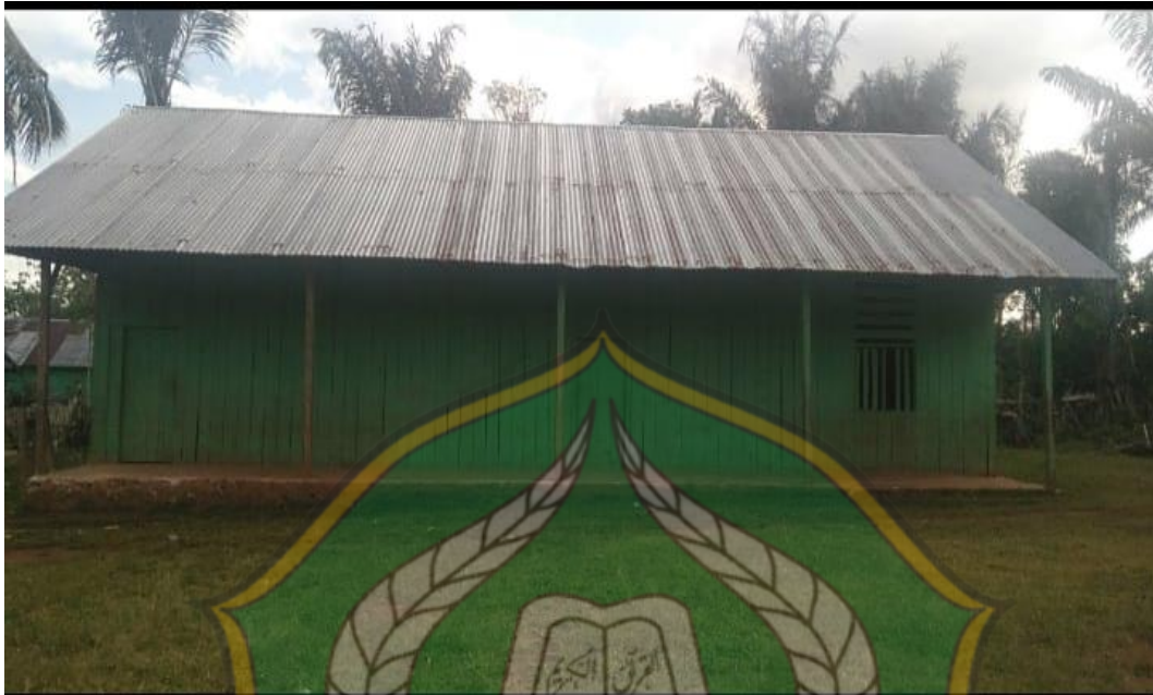
17. (Dokumentasi gedung MTS Miftahul Jannah Umba di Bangkali)
