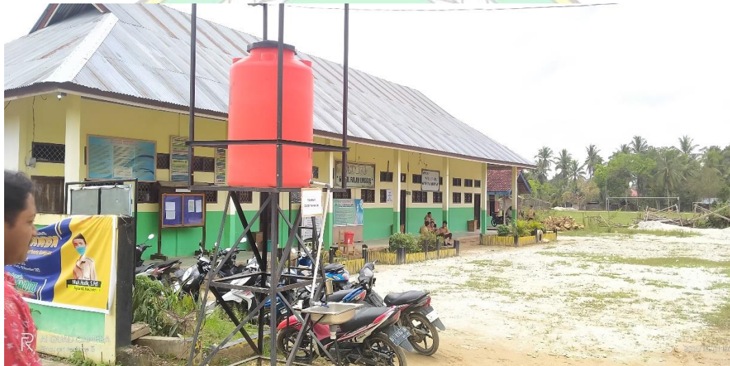
Gambar 2. Keadaan Gedung MA Nurul Falah Kab. Konawe Selatan.
